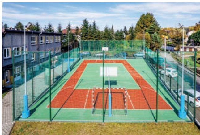
■ Gmina zbudowała nowe szkolne obiekty sportowe
