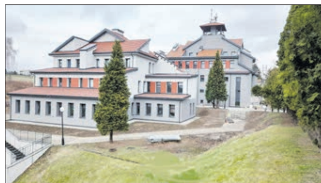
■ Szkoła w Połomi po termomodernizacji
