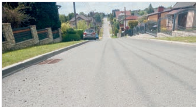
■ Remont ul. Żużlowej
