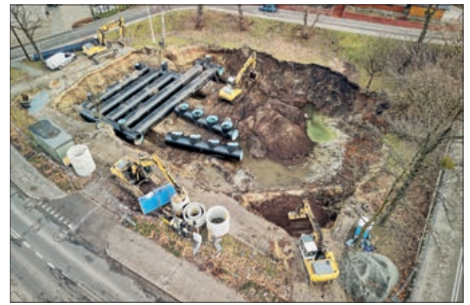
■ Prace przy ulicy Ofiar Terroru FOT. UM RYDUŁTOWY
