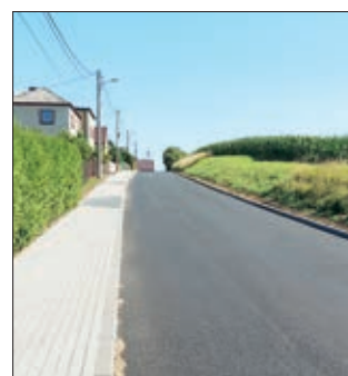
■ Remont drogi gminnej – ul. Cicha w Bojanowie
