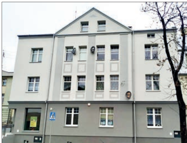
■ Termomodernizacja miejskich budynków
