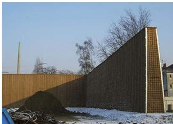
Rysunek 13. Przykładowy ekran akustyczny – ziemny ekran akustyczny z konstrukcją stalową. [Źródło: Ecotec Polska]
